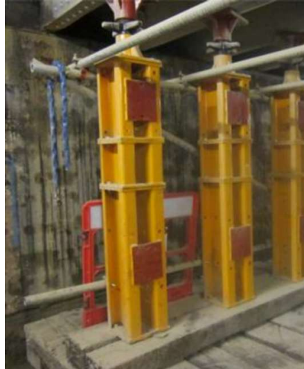
Apuntalamiento tipo Estructura Metálica.
