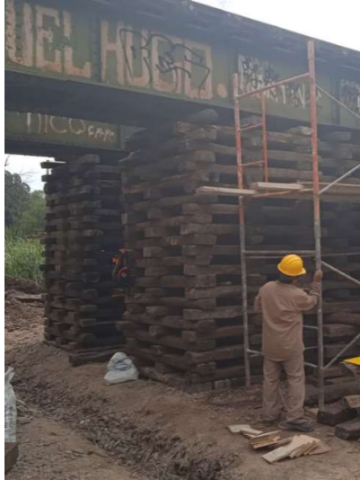
Apuntalamiento tipo Pilastra.
