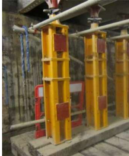
Apuntalamiento tipo Estructura Metálica.
