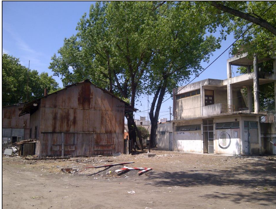
ACCESO DE CAMIONES ACTUAL Y VISTA POSTERIOR DE EDIFICIO A DEMOLER PARA CONSTRUCCION DE TALLER DE BARRERAS
