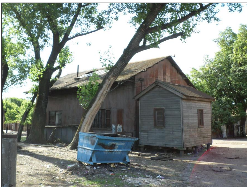
GALPON y CASILLA A DEMOLER PARA CONSTRUCCION DE TALLER DE BARRERAS NUEVO
