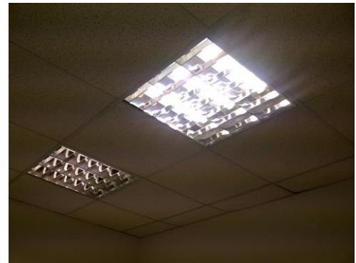
Plafón de luz fluorescente de 2x36 de estructura de chapa pintado al horno con esmalte color blanco y lúver doble parabólico metálico.
