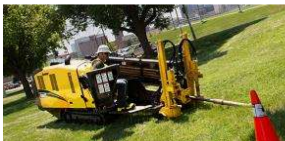
Imagen 4 - Perforación horizontal dirigida.
