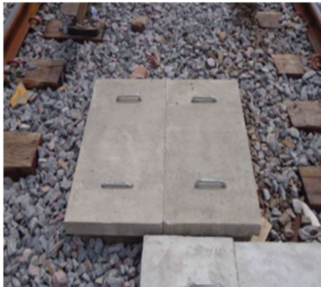
Imagen 8 – Tapa de cámara de inspección
