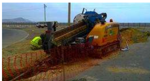
Imagen 4 - Perforación horizontal dirigida.
