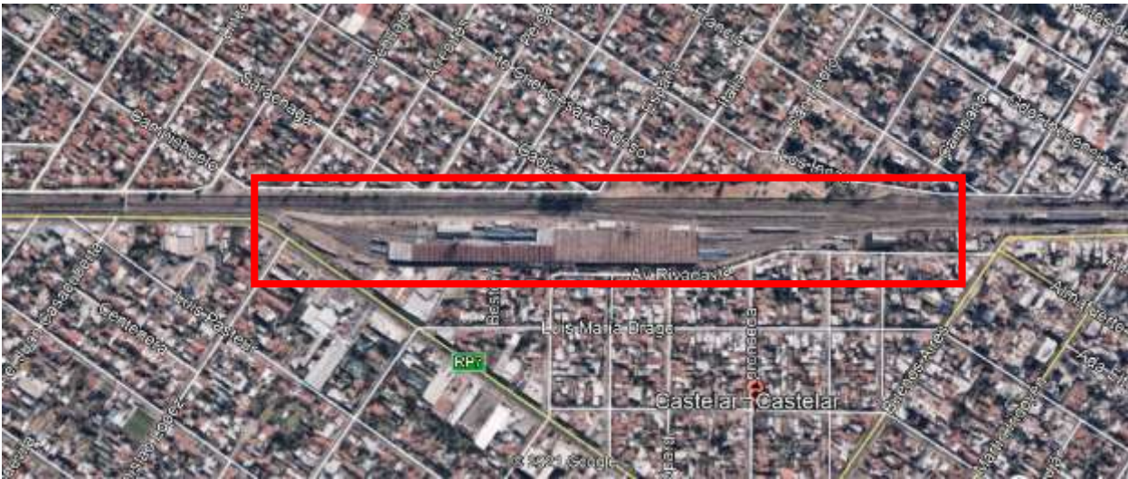
Imagen 3 - Vista aérea del Predio Castelar.
