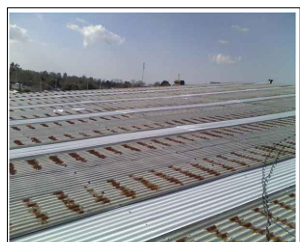
IMAGEN NAVE 0- (Acceso)
