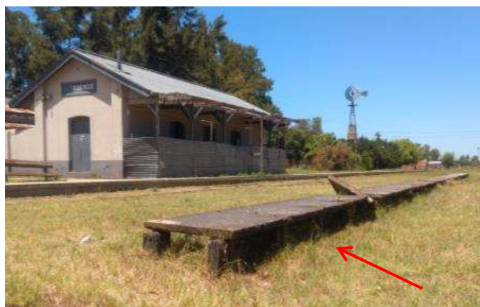
Imagen 5: Pasarela de losetas a retirar – Est. Hornos
