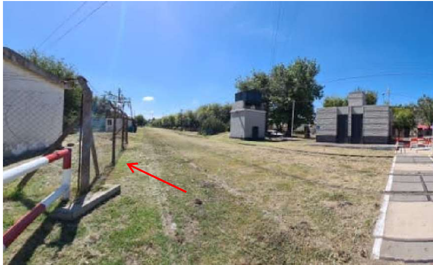
Imagen 23: Cerco existente a reubicar – Est. Las Heras
