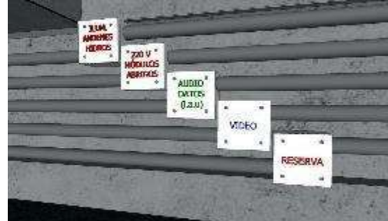
DISPOSICIÓN DE TENDIDOS DE ELECTRICOS Y CAJAS
