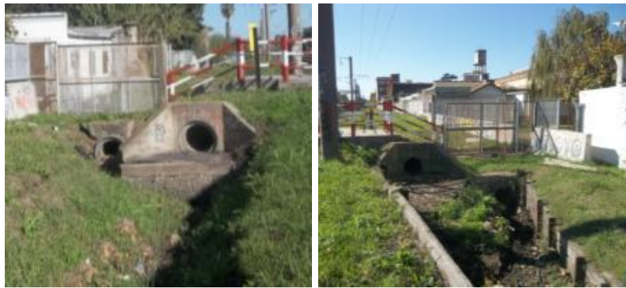
Fotografías 5 Acometida a paso peatonal Gral. Paz. Aguas arriba (Izq.) y aguas abajo (Der.)
