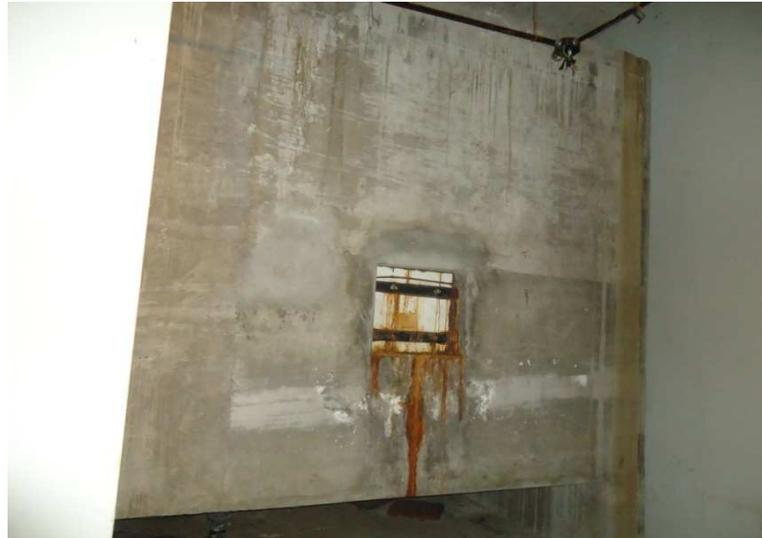
LA CONTRATISTA ejecutará la reparación de la aislación hidrófuga y revoque del tanque de reserva del sistema contra incendio.
