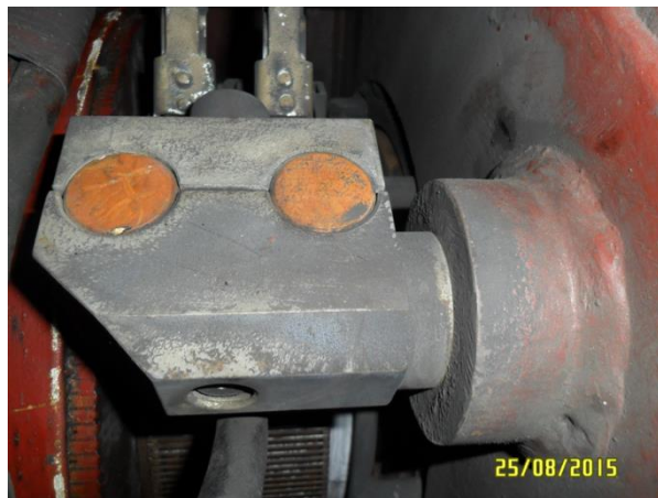
Figura N° 1 - soldadura en el lado interior del motor
