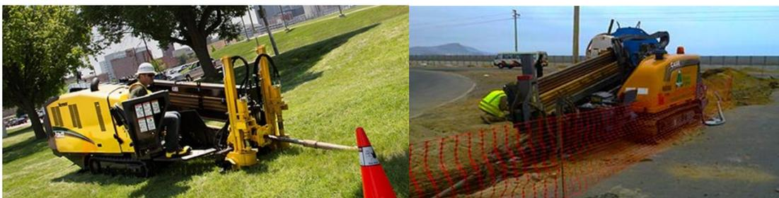
Imagen 1: Perforación horizontal dirigida
