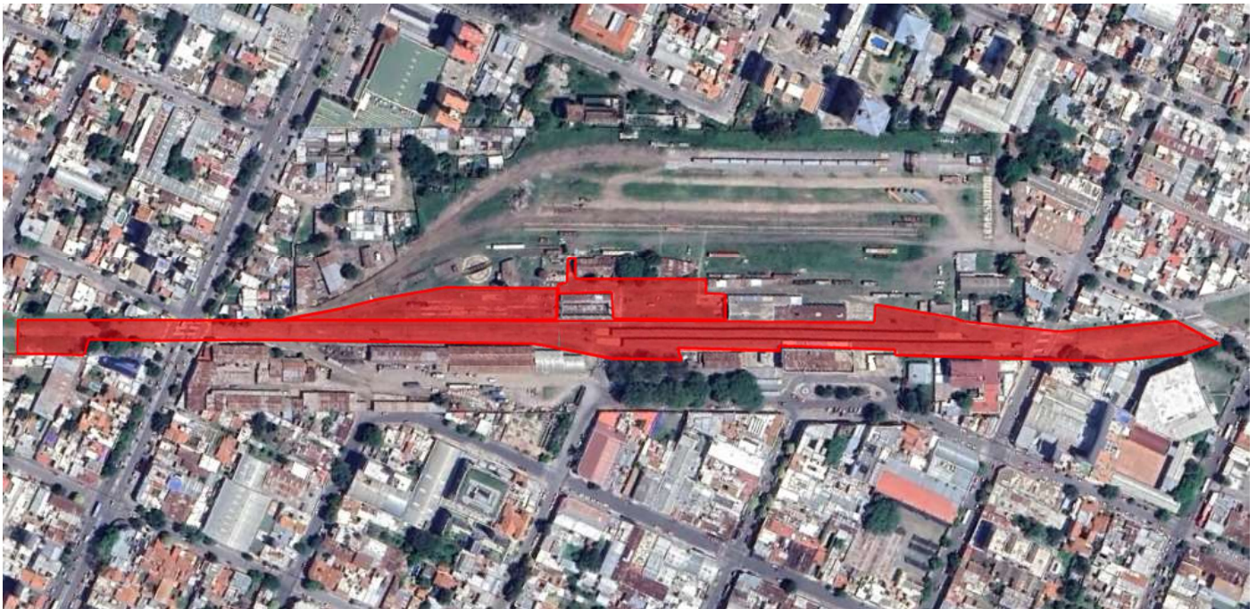
Estación Salta – Pk 1132+630
