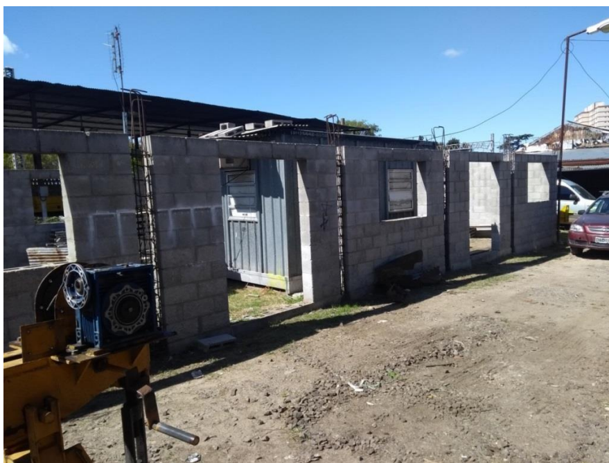
Edificación de bloque de H abandonada - Situación actual.
