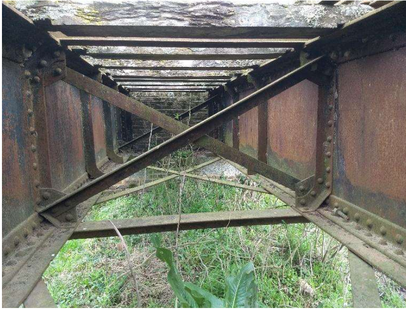
Vista entre vigas desde sección central
