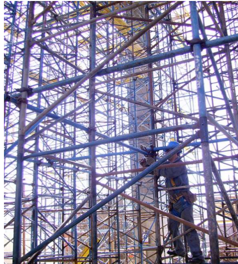
Apuntalamiento tipo Caño y Nudo.
