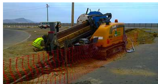
Imagen 1: Perforación horizontal dirigida
