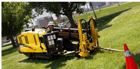
Imagen 1: Perforación horizontal dirigida
