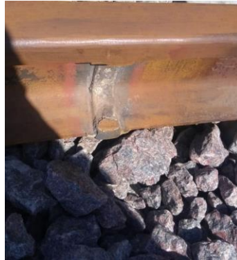
Ejemplo de terminación de esmerilado pretendida
