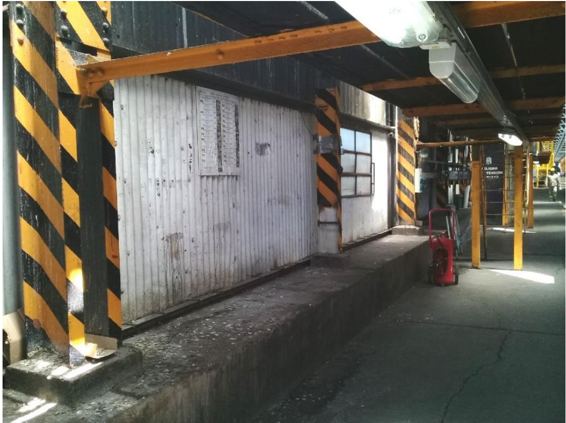
Zona de emplazamiento de las nuevas instalaciones
