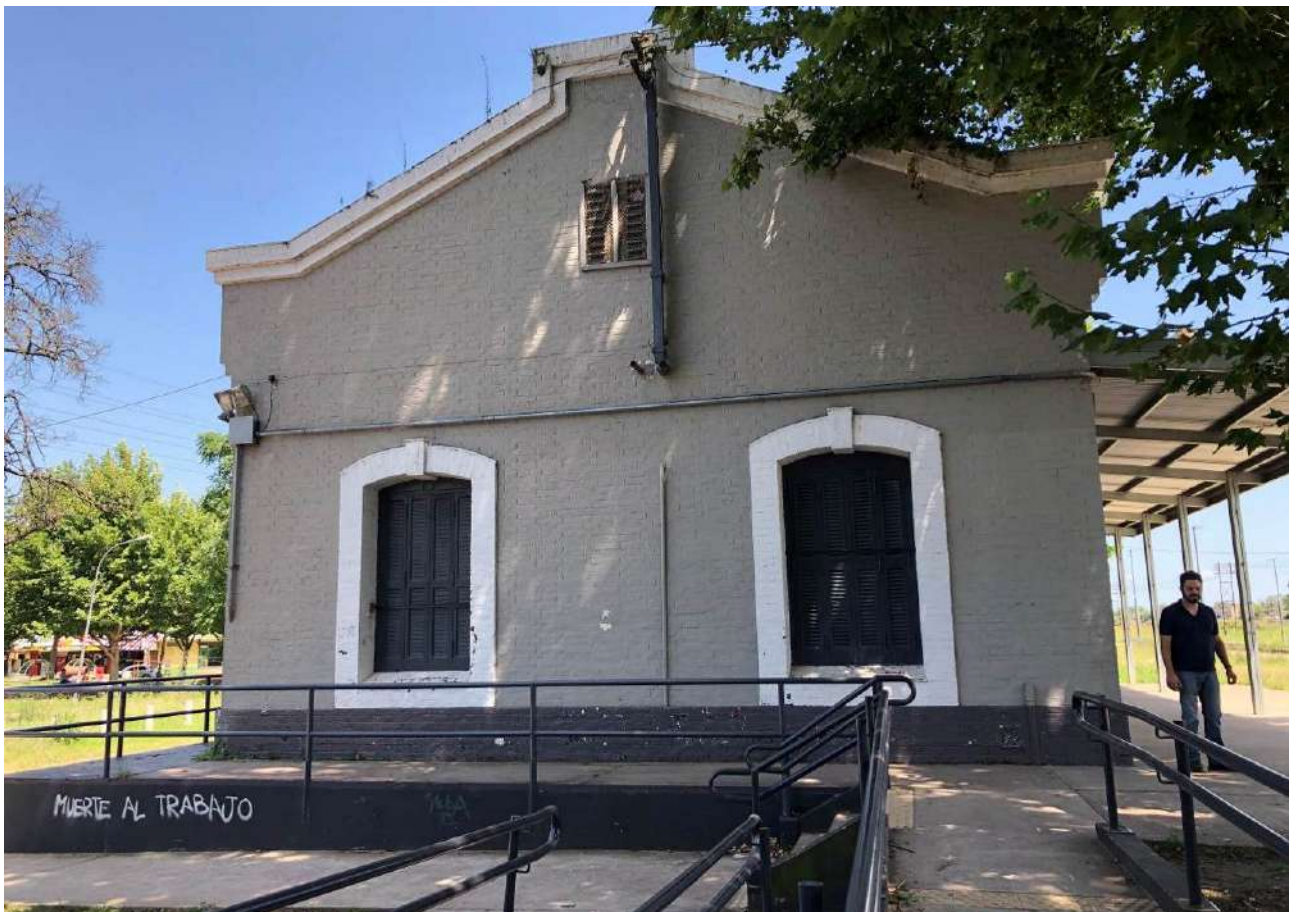
Acceso por vereda perimetral y rampa al Edificio de Estación y andenes
