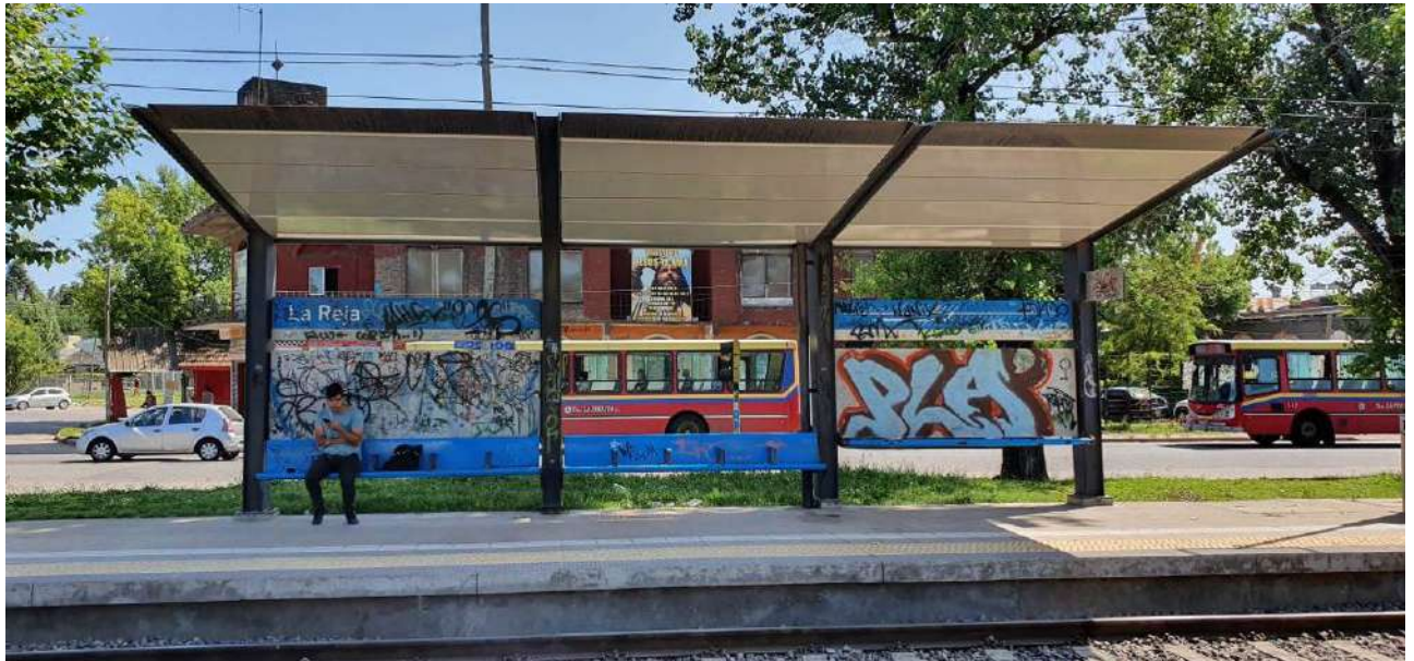
Refugio metálico – Sector andenes
