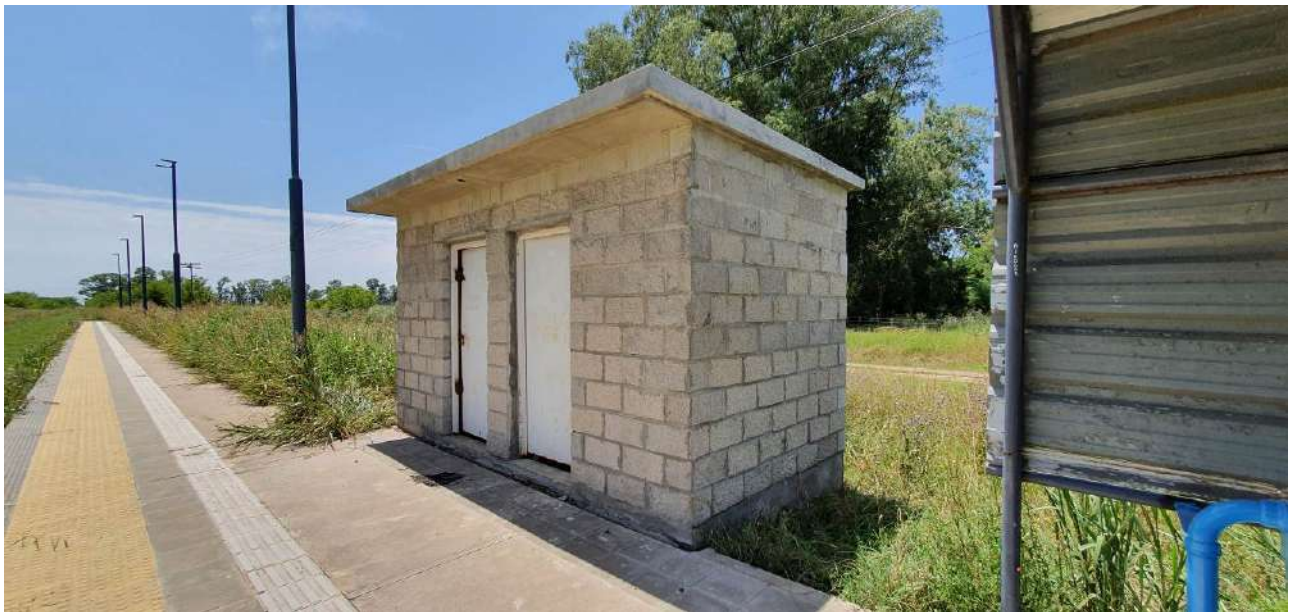
Refugio bloques de hormigón
