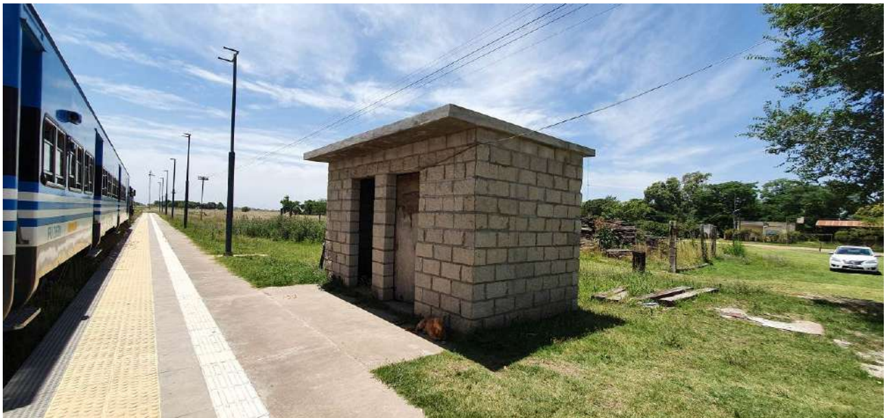
Refugio de bloques de hormigón
