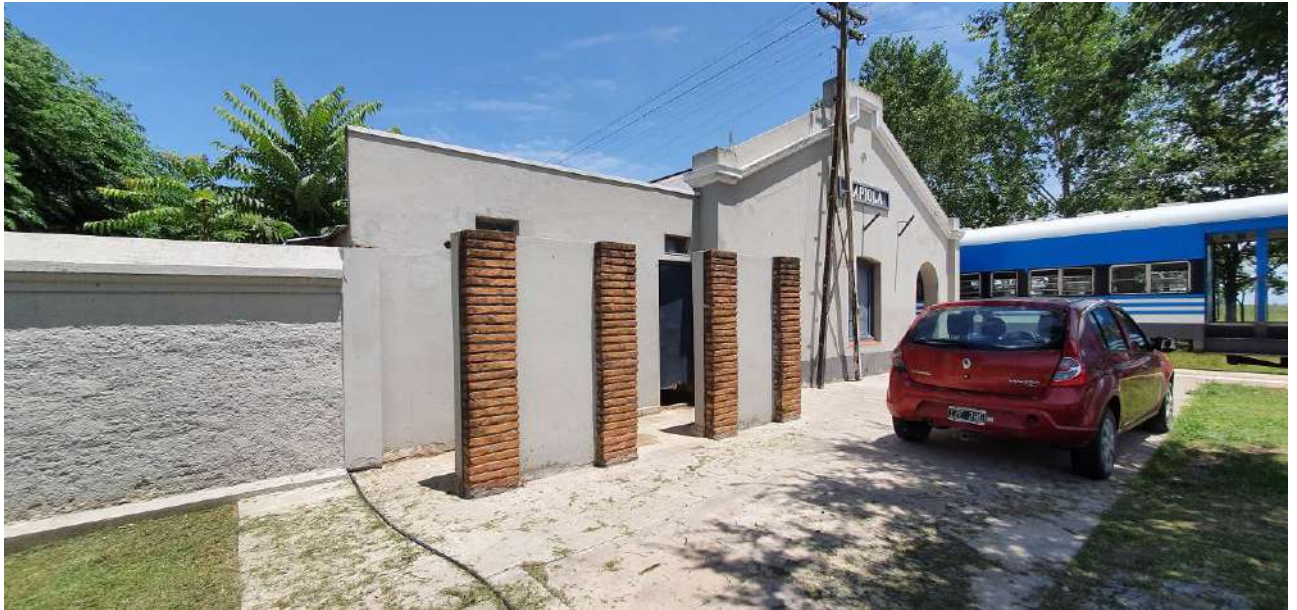
Sector acceso peatonal y baños clausurados
