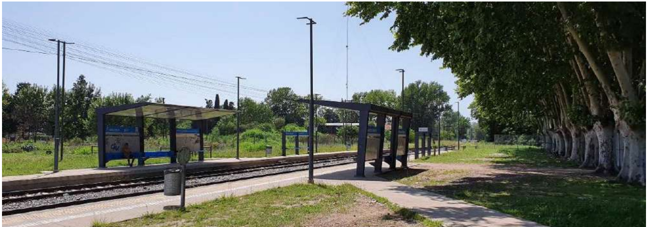
Acceso sector andenes
