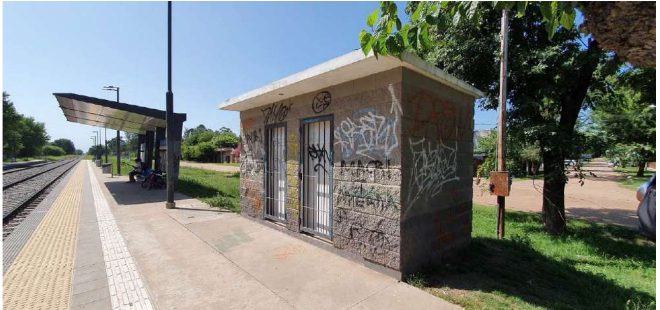
Sector andenes y refugios metálicos y de bloques de hormigón
