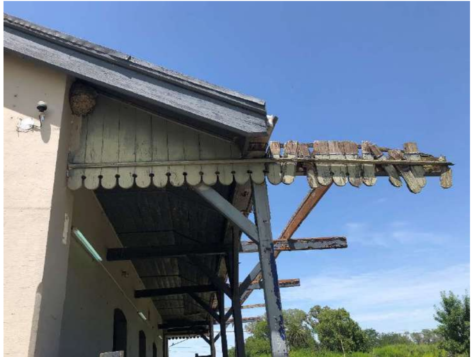
Edificio Estación – sector semicubierto (estructura de madera)
