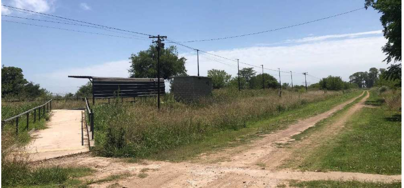
Acceso por rampa al único andén
