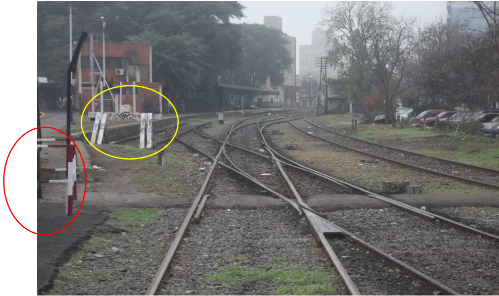
Fotografía 2 Vista del paragolpe existente a la izquierda. La vía nueva será construida entre éste y el laberinto peatonal que se observa a la izquierda de la imagen.
