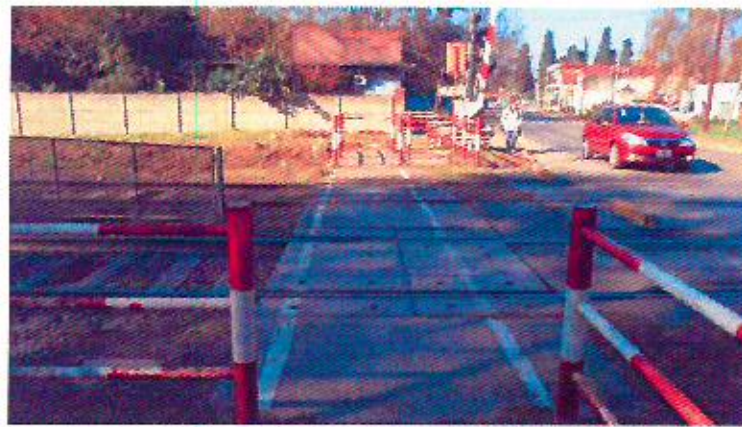
Foto 44: Pasillo peatonal y laberintos fuera de norma.
