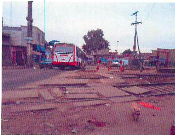
Foto 50: Pasillo peatonal y laberintos fuera de norma,
