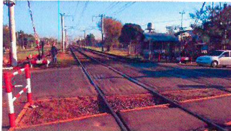
Foto 36: Estado actual del PaN.
