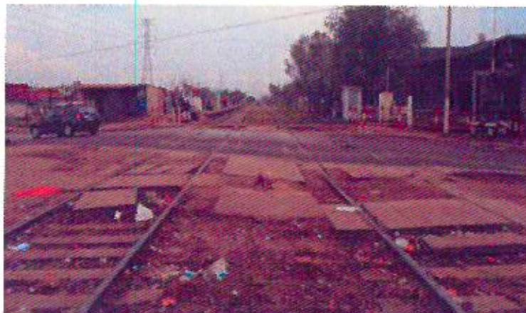
Foto 48: Estado de la calzada vehicular y peatonal.
