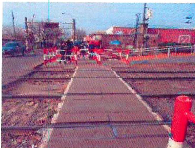
Foto 18: Pasillo peatonal y laberintos fuera de norma.
