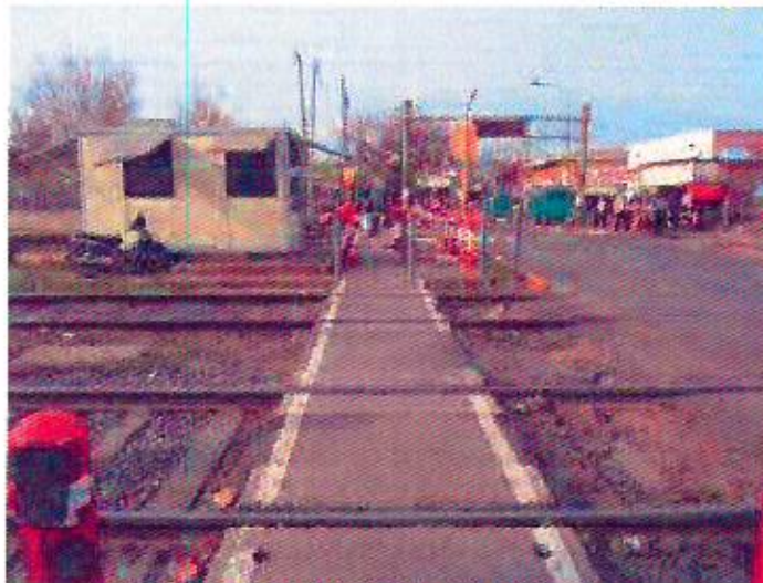
Foto 15: Pasillo peatonal y laberintos fuera de norma.
