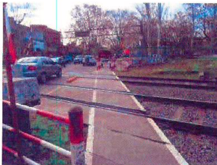
Foto 7: Pasillo peatonal y laberintos fuera de norma.
