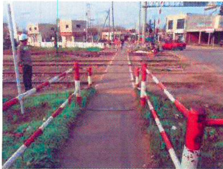
Foto 27: Pasillo peatonal y laberintos fuera de norma.
