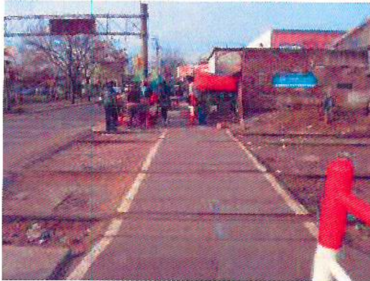
Foto 16: Pasillo peatonal y laberintos fuera de norma.
