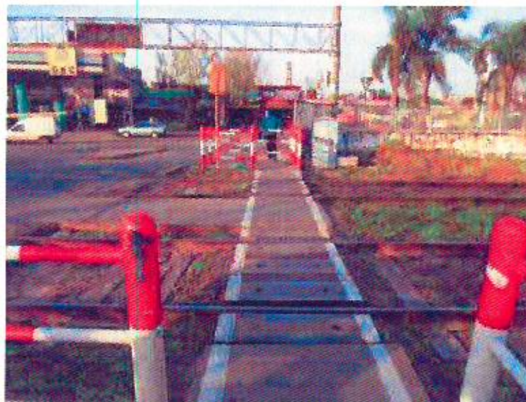
Foto 11: Pasillo peatonal y laberintos fuera de norma.
