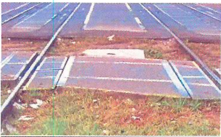
Foto 34: Las losetas deberán cubrir de forma continua desde senda peatonal o senda peatonal.
