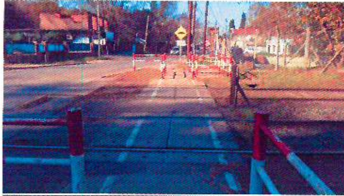
Foto 45: Pasillo peatonal y laberintos fuera de norma.
