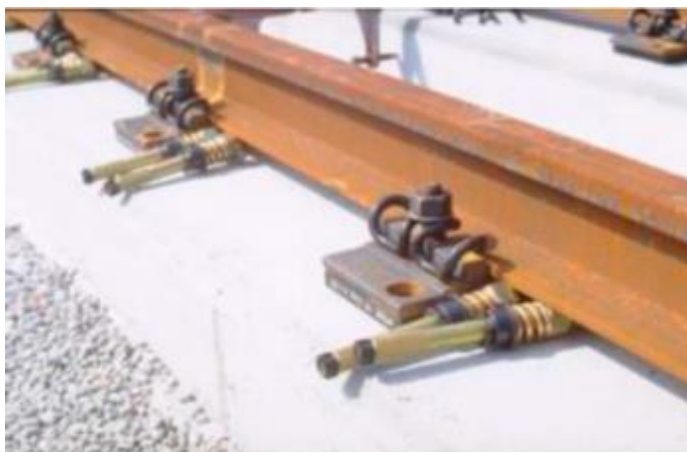
Imagen: Placa de fijaciones de vías.
