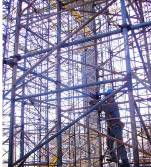
Apuntalamiento tipo Caño y Nudo.
