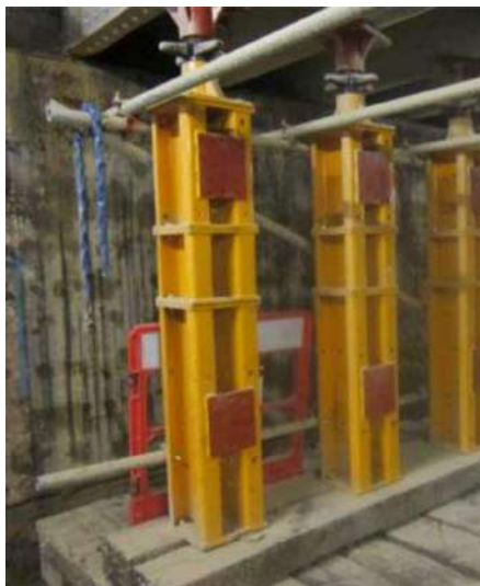
Apuntalamiento tipo Estructura Metálica.
