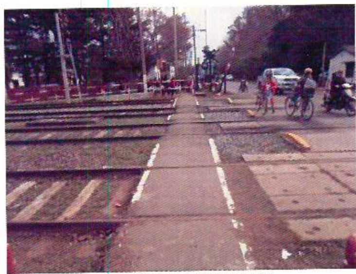
Foto 49: Pasillo peatonal inexistentes.
