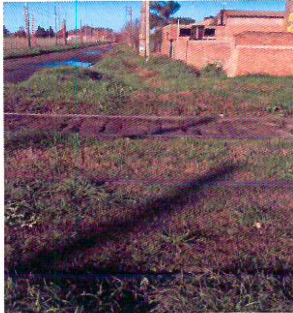
Foto 15: Pasillo peatonal inexistentes.
