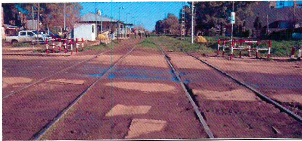
Foto 10: Calzada vehicular en mal estado.
