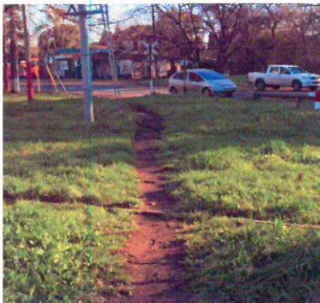
Foto 21: Pasillo peatonal inexistentes.
