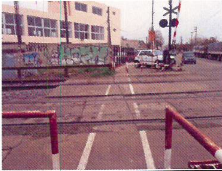
Foto 71: Pasillo peatonal y laberintos fuera de norma.
