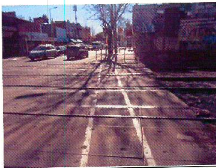
Foto 75: Pasillo peatonal y laberintos fuera de norma.
