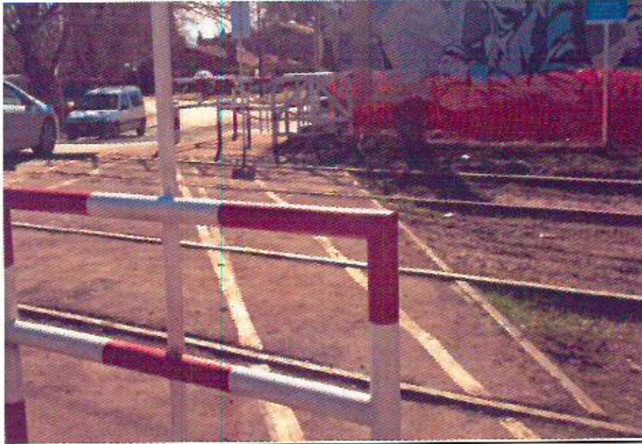
Foto 26: Pasillo peatonal y laberintos fuera de norma.
