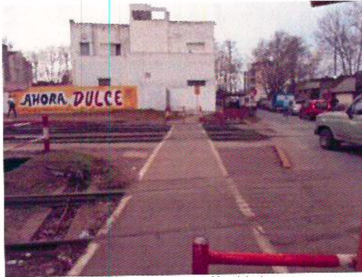
Foto 44: Pasillo peatonal inexistentes.
