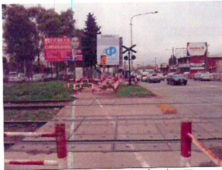
Foto 62: Pasillo peatonal y laberintos fuera de norma.
