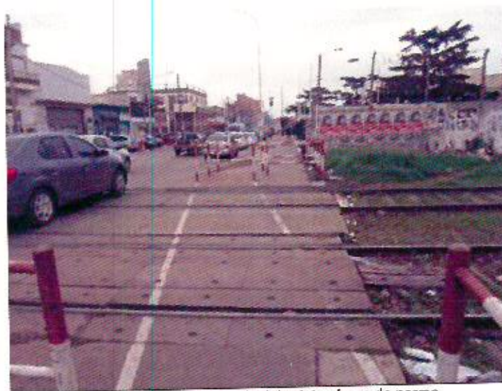
Foto 61: Pasillo peatonal y laberintos fuera de norma.
