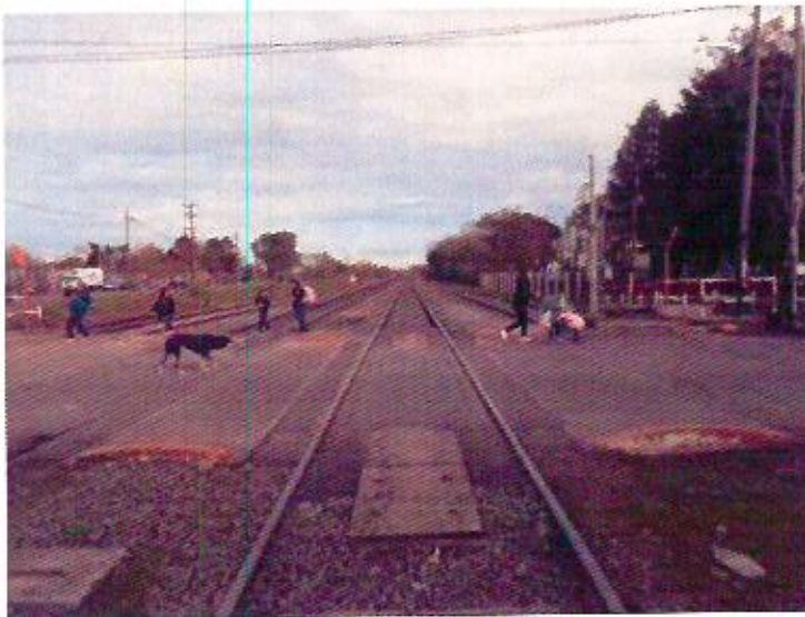
Foto 50: Pasillo peatonal inexistentes.
