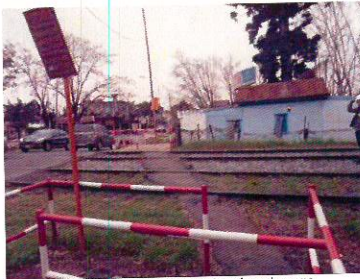
Foto 65: Pasillo peatonal y laberintos fuera de norma.
