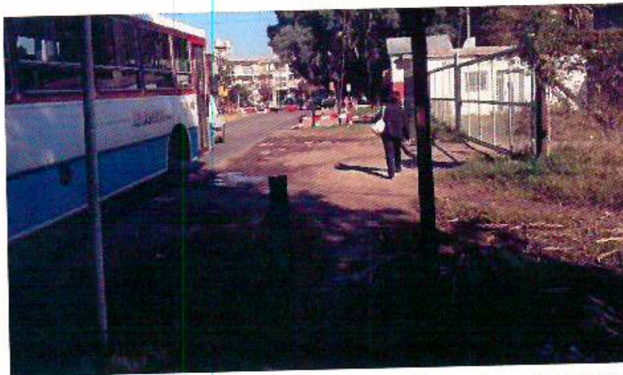
Foto 79: Las losetas cubrirán la calzada y sendas peatonales. Conservar barras de accionamiento.
