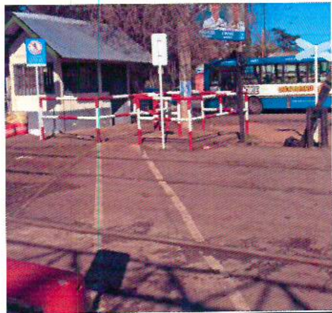
Foto 25: Pasillo peatonal y laberintos fuera de norma.
