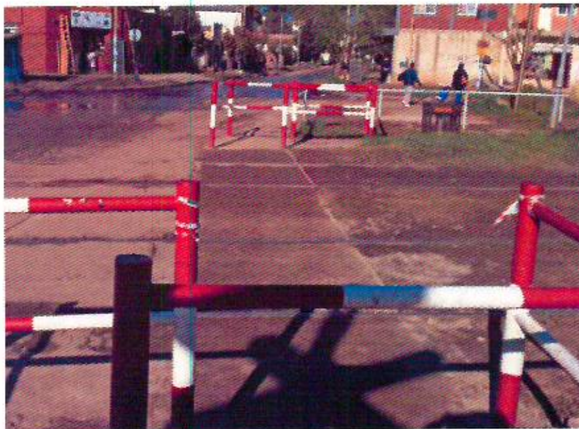
Foto 11: Pasillo peatonal y laberintos fuera de norma.
