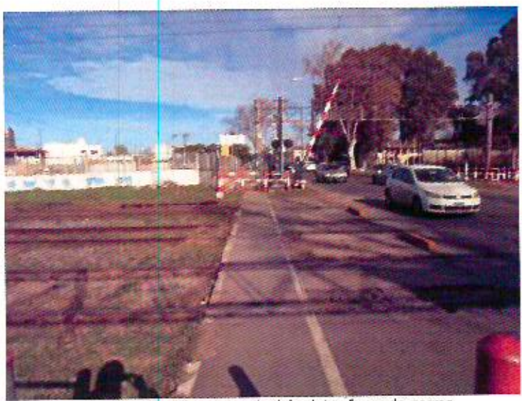
Foto 31: Pasillo peatonal y laberintos fuera de norma.
