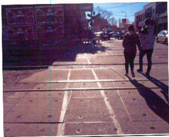
Foto 76: Pasillo peatonal y laberintos fuera de norma.
