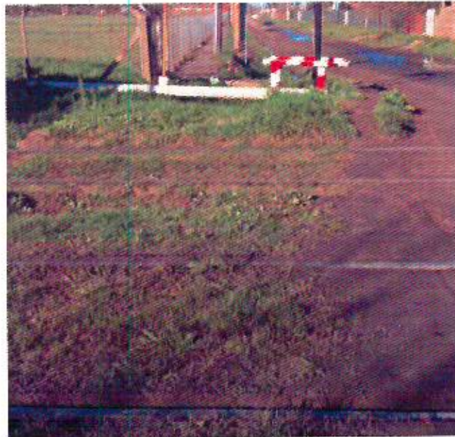
Foto 16: Pasillo peatonal inexistentes.
