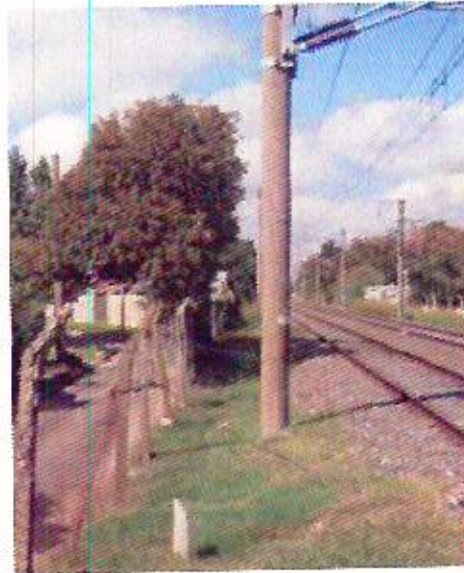
Foto 78: Mojón indicando línea de 13,2 kV enterrada y poste de catenaria energizada a 25 kV.
