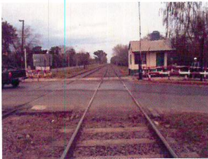
Foto 40: Pasillo peatonal y laberintos fuera de norma.
