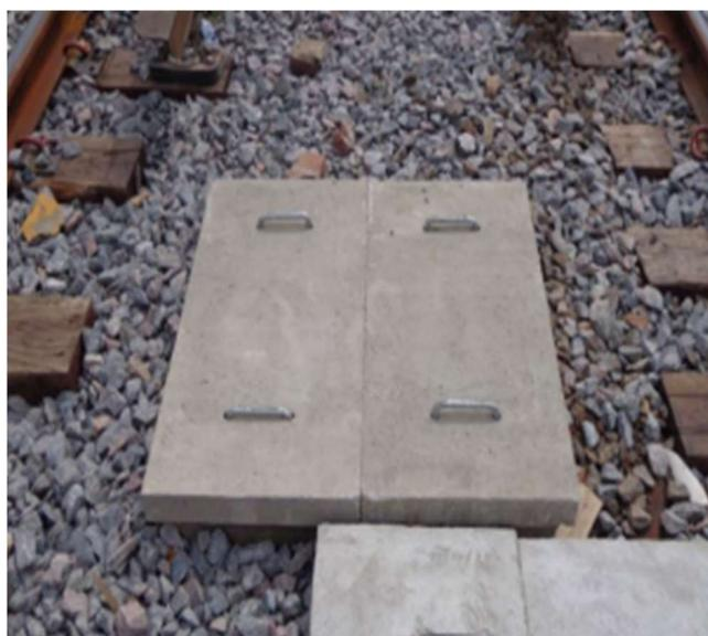
Imagen 8 – Tapa de cámara de inspección
