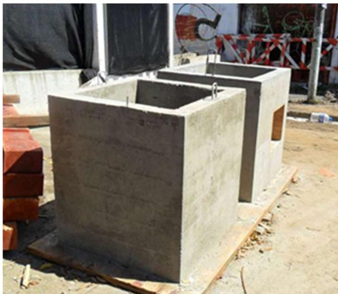
Imagen 7 - Cámara de inspección de referencia
