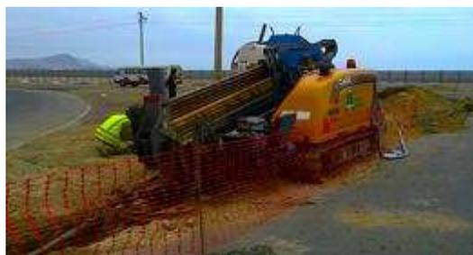
Imagen 4 - Perforación horizontal dirigida.
