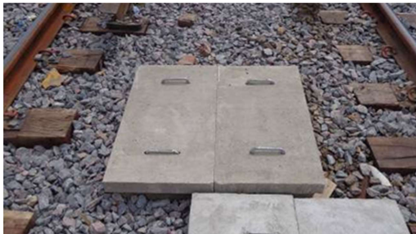
Imagen: Detalle de cámara de inspección.
