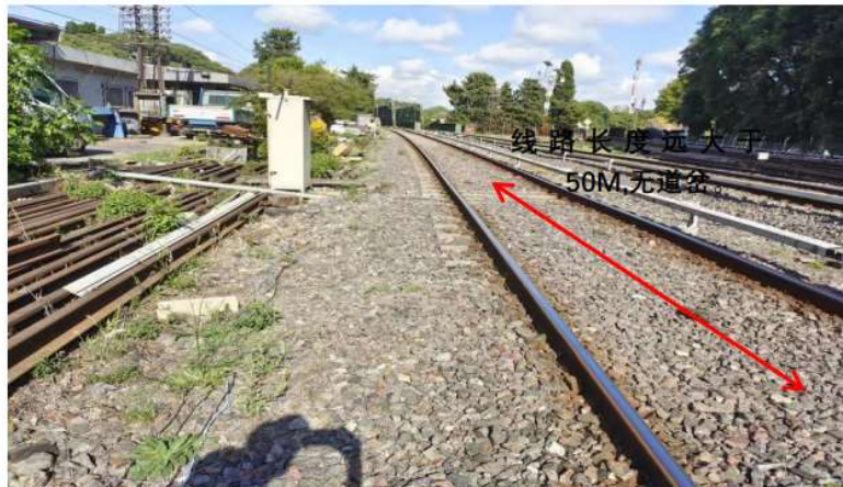
Figura 3- Vía principal de la circulación de formaciones
