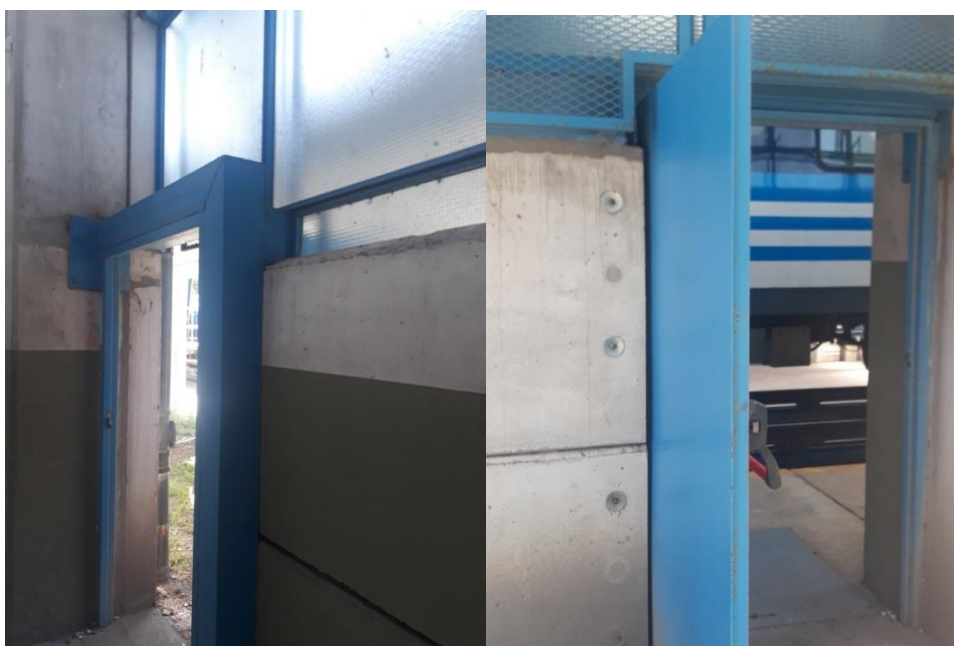
Vista desde el interior de la nave
