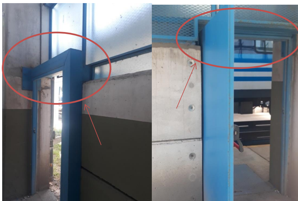
Vista desde el interior de la nave
