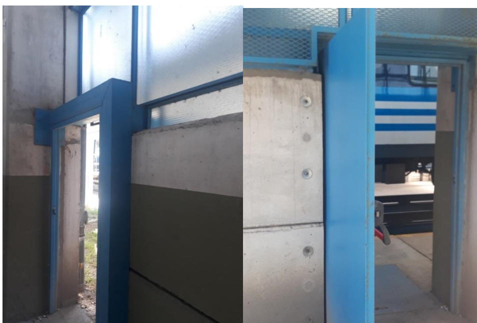
Vista desde el interior de la nave
