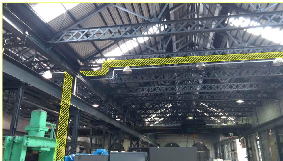
NUEVO TENDIDO DE BANDEJA SIMILAR AL EXISTENTE PARA EL CORRECTO FUNCIONAMIENTO DEL TORNO
