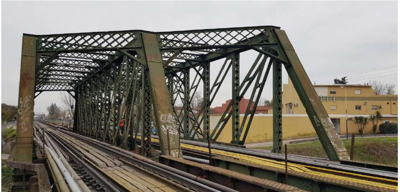
Vista sobre Vía
