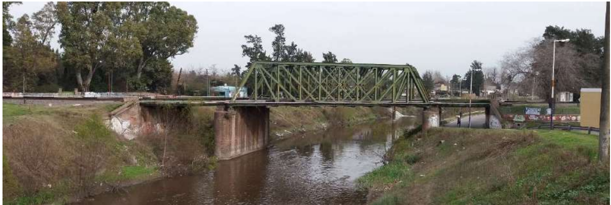
Vista de lado descendente
