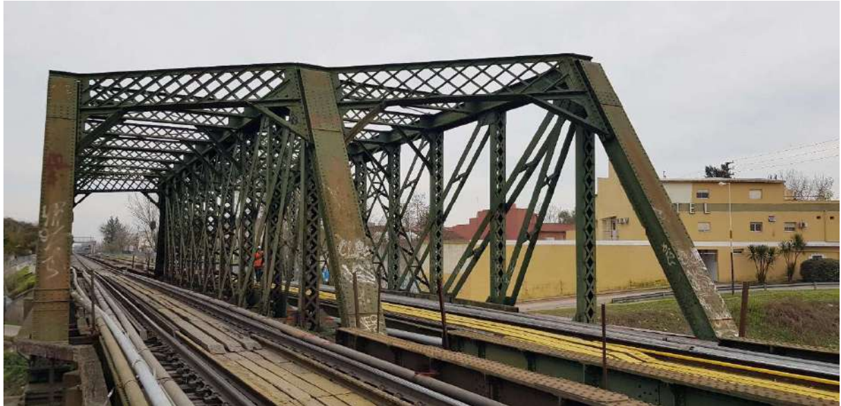
Vista sobre Vía
