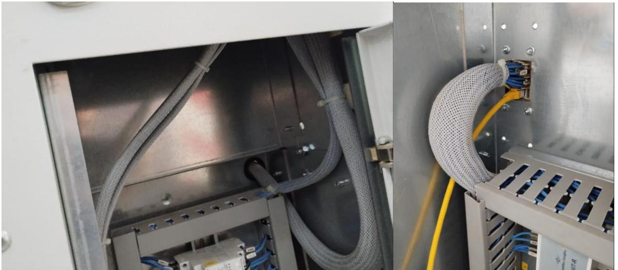
Para el cableado de las entradas y salidas digitales del equipo de control y protección SEPCOS de SECHERON a colocar por la Contratista, la sección mínima permitida será de 0,75 mm<sup>2</sup>.
