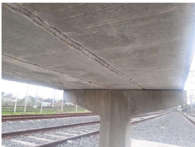
Detalles de losetas pretensadas y carga de compresión.
