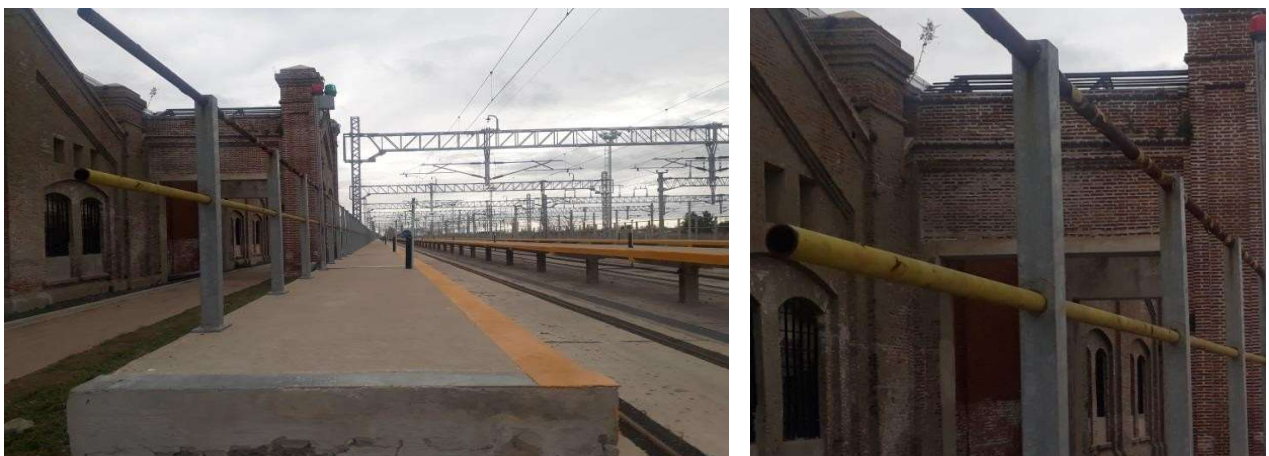
Barandas dobles con parante ángulo galvanizado en andenes 1 y 2.
