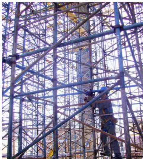
Apuntalamiento tipo Caño y Nudo.
