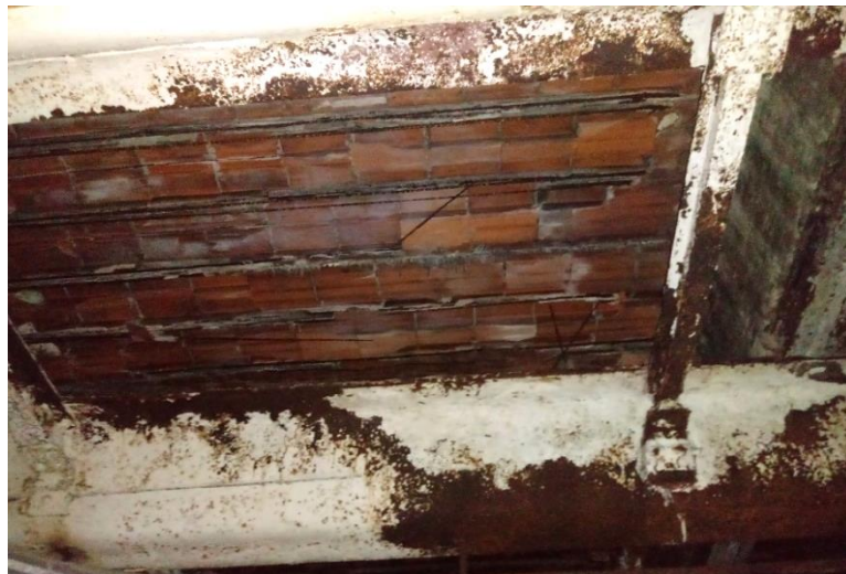
Vista bajo losa andén 4-5, Galpón 6 (P. 0,250)
