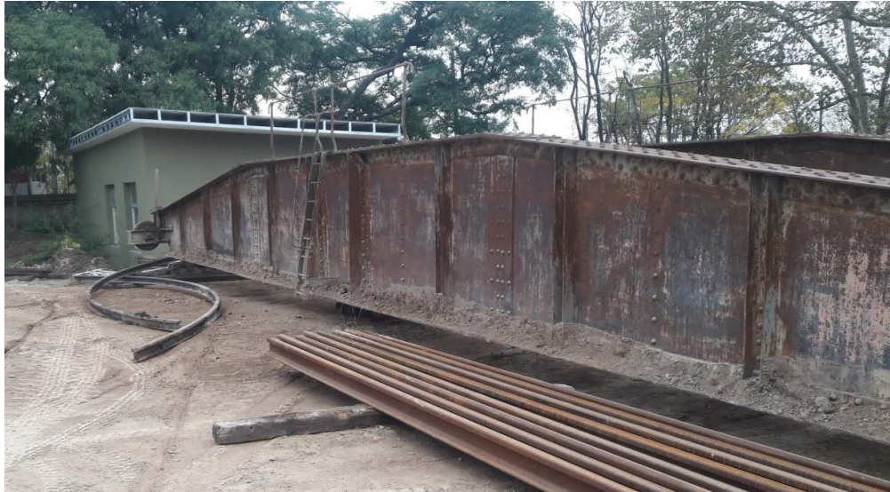
Fotografía 2: Estado actual de la mesa giratoria (06/2017)
