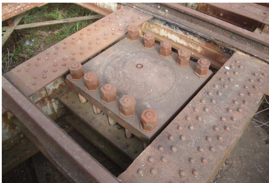
Fotografía 3 Detalle de los espárragos roscados a proveer por el Contratista.
