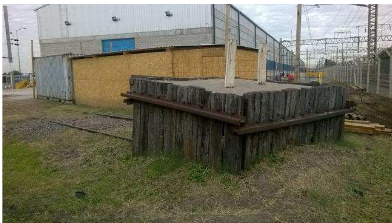
Fotografía 5: Paracolpe a demoler.
