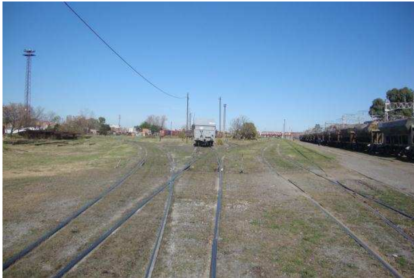
Fotografía 6 vista hacia el norte del lugar de implantación de la mesa giratoria.
