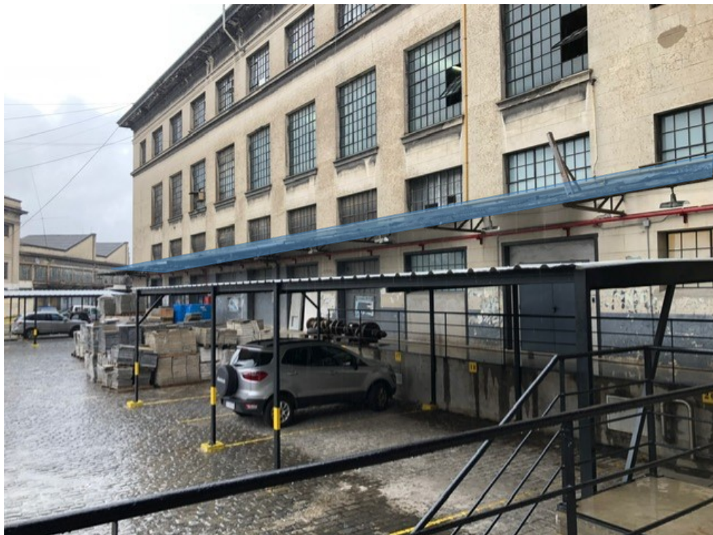
Cubierta perimetral a Playa de Carga
