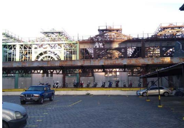
Estructura sector Estacionamiento de motos
