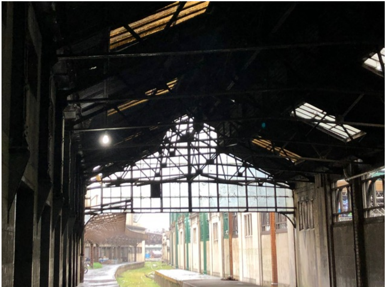
Pantalla de cierre Sur – Cubierta de Andenes 15 y 16 (vista interior)
