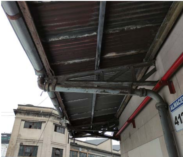
Sistema Pluvial existente – Cubierta perimetral a Playa de Carga
