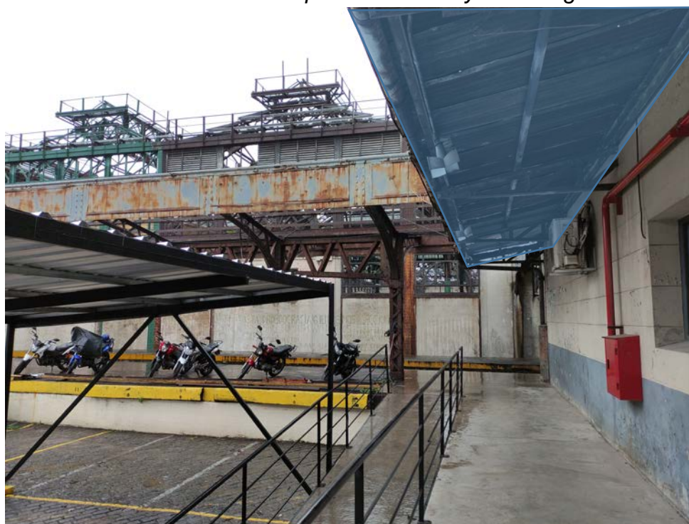
Sector de cubierta perimetral a Playa de Carga
