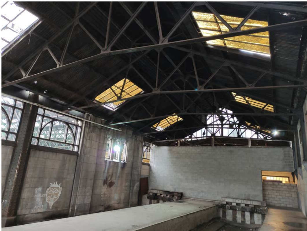
Cubierta sobre Andenes 15 y 16
