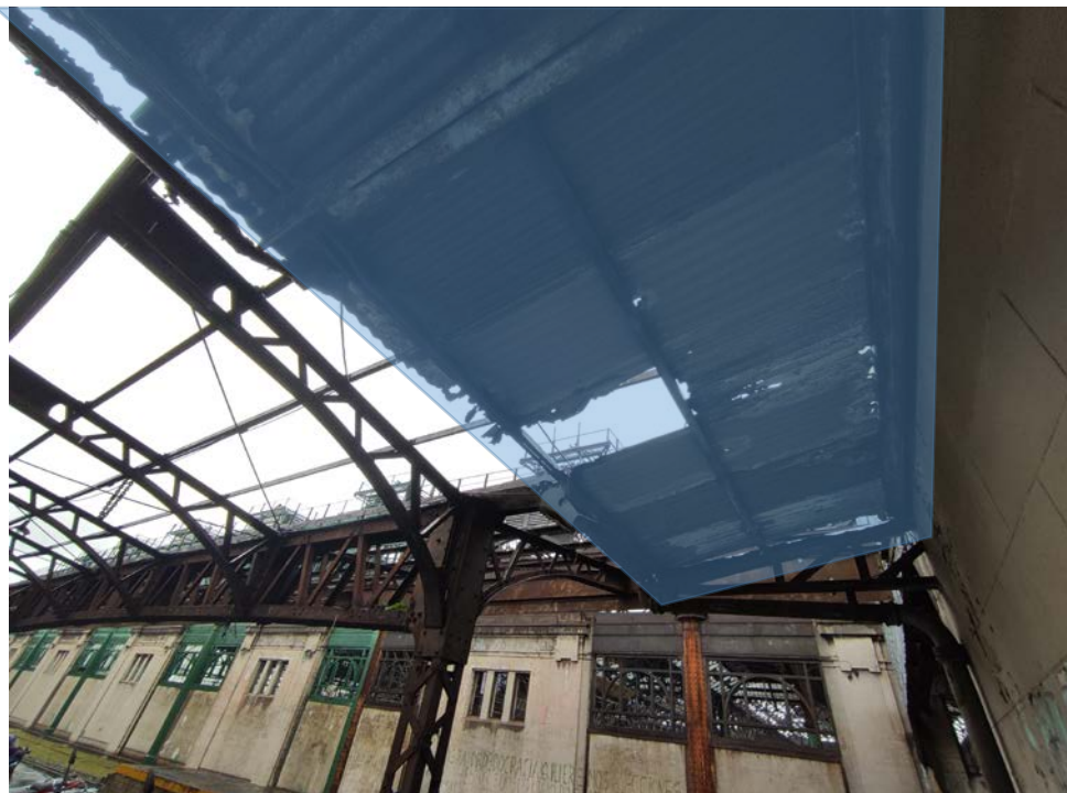
Sector de cubierta perimetral a Playa de Carga
