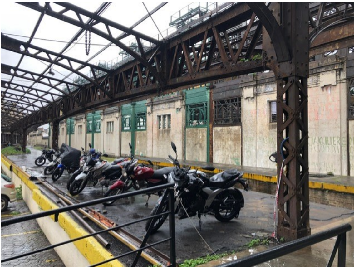
Estructura sector Estacionamiento de motos
