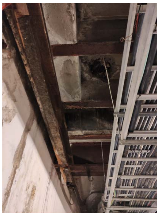
Sectores de Subsuelo con humedades por filtraciones
