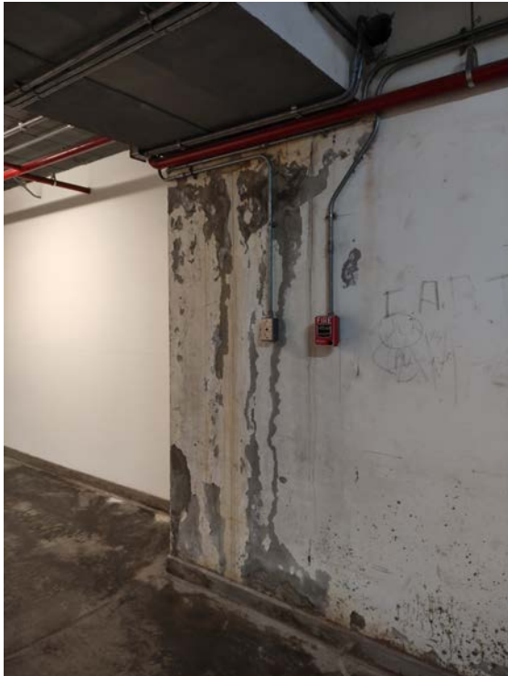
Sectores de subsuelo afectados por filtraciones
