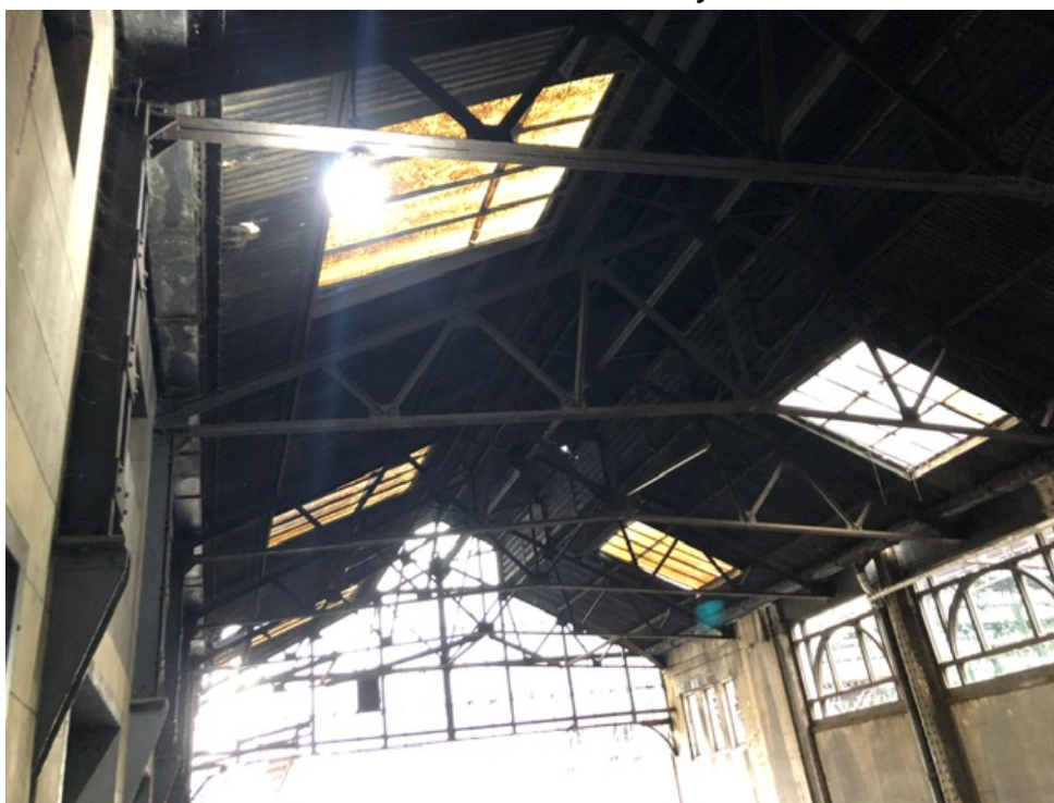
Cubierta de Andenes 15 y 16
