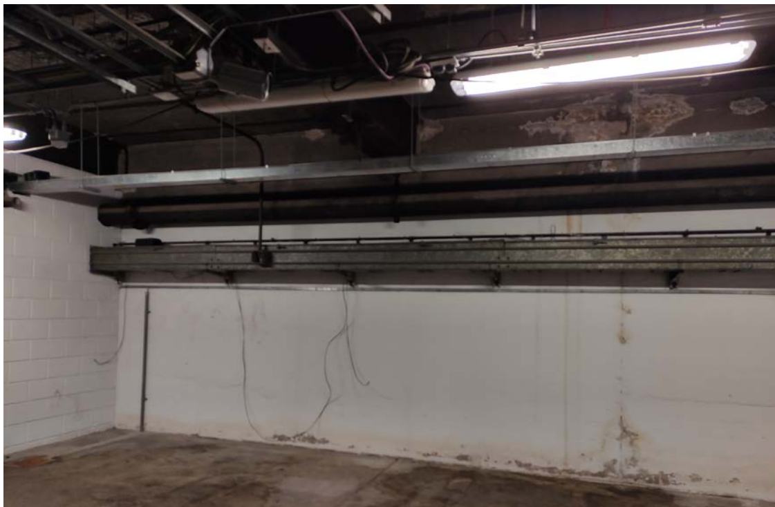
Sectores de subsuelo afectados por filtraciones
