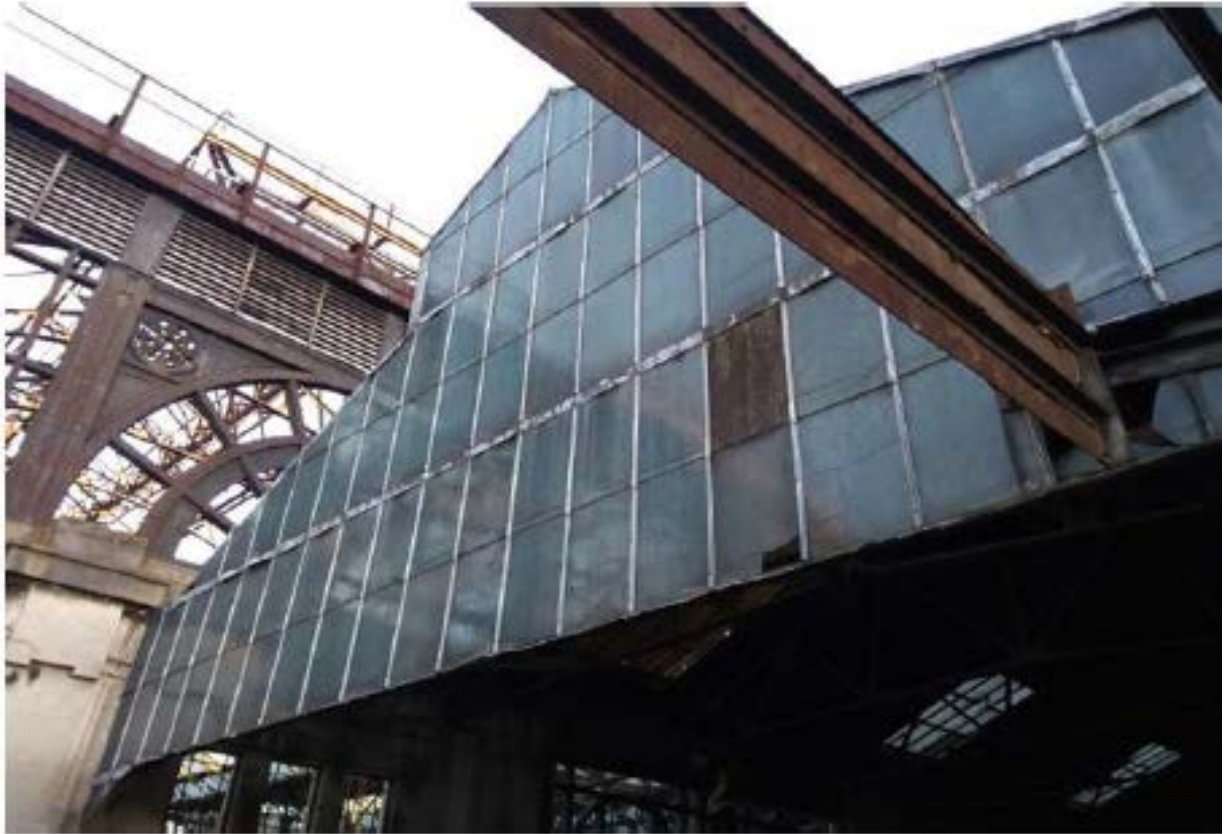
Pantalla de cierre Sur – Cubierta de Andenes 15 y 16 (vista exterior)
