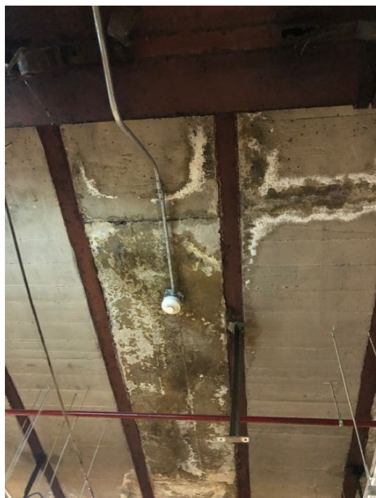
Sectores de Subsuelo con humedades por filtraciones
