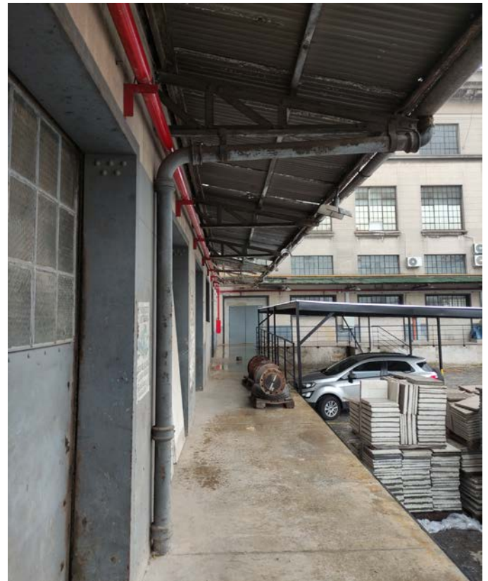
Sistema Pluvial existente – Cubierta perimetral a Playa de Carga
