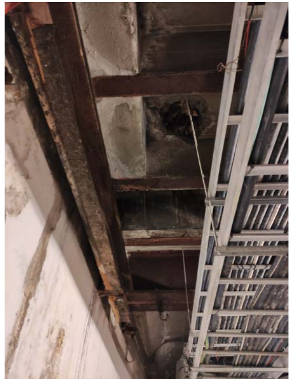
Sectores de subsuelo afectados por filtraciones
