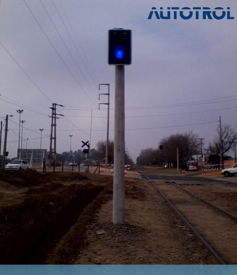
SEMÁFORO TESTIGO DE ESTADO DE BARRERA STEB-DMB-CCT
