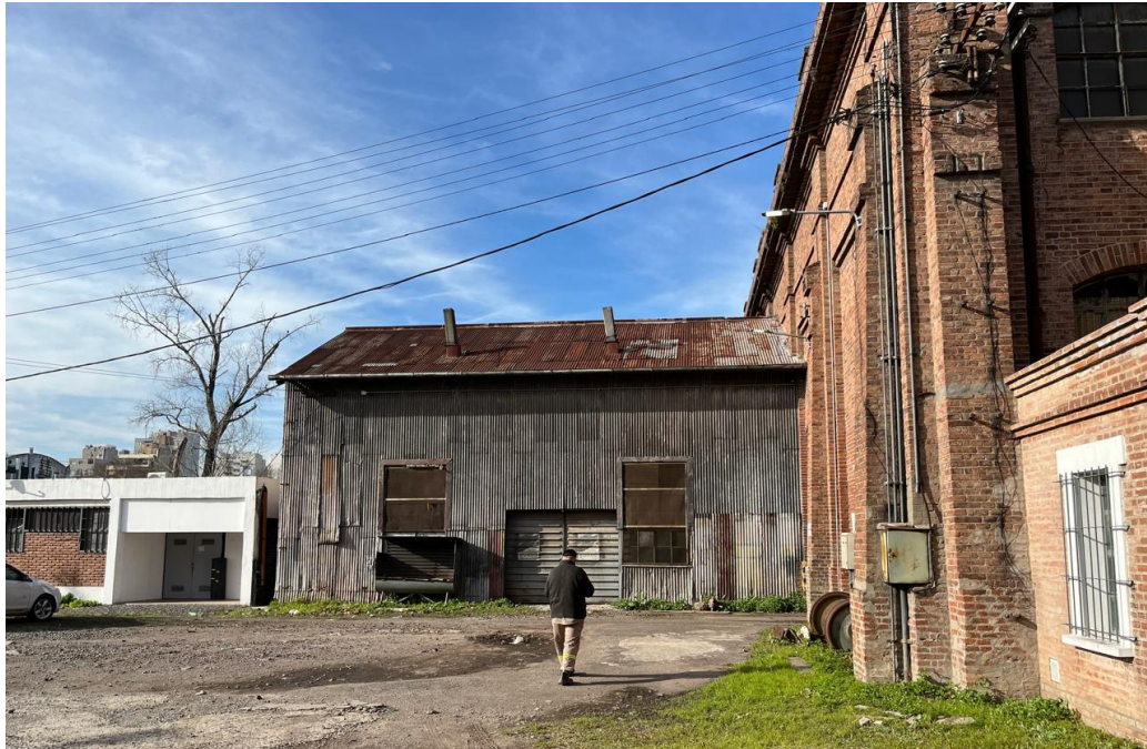
- Taller de Herrería Existente (Exterior)
