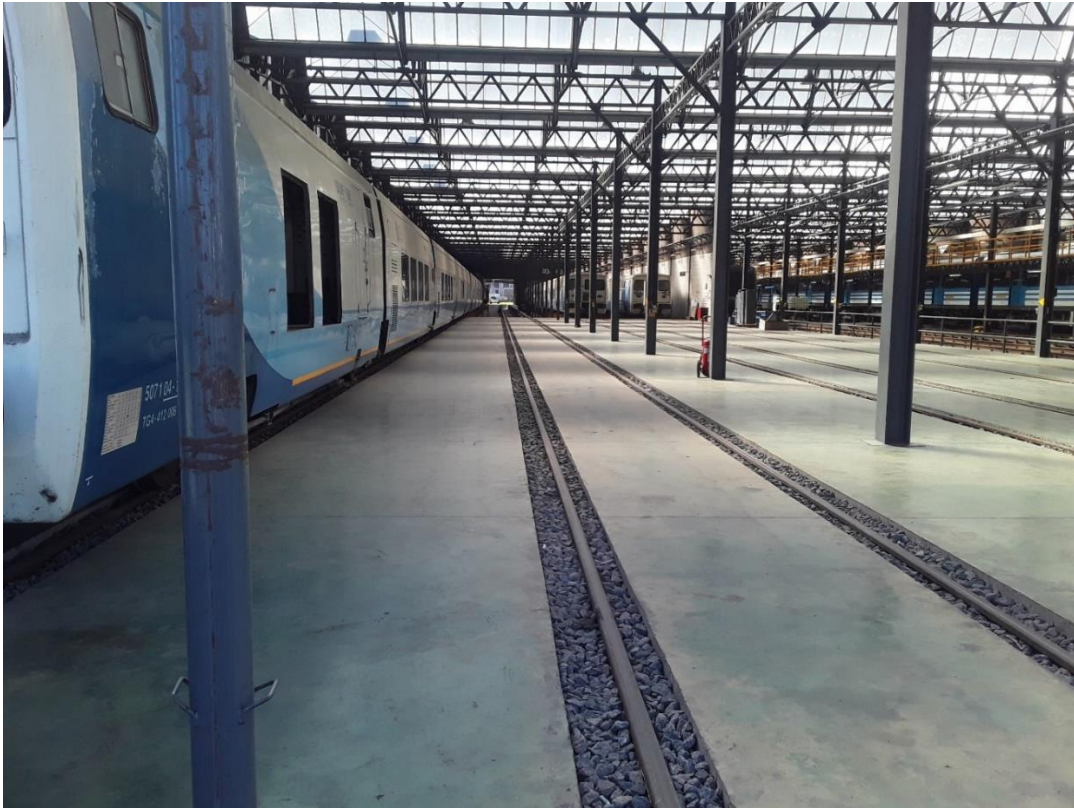
Espacio con piedra balasto a ser relleno con bitumen asfáltico.
