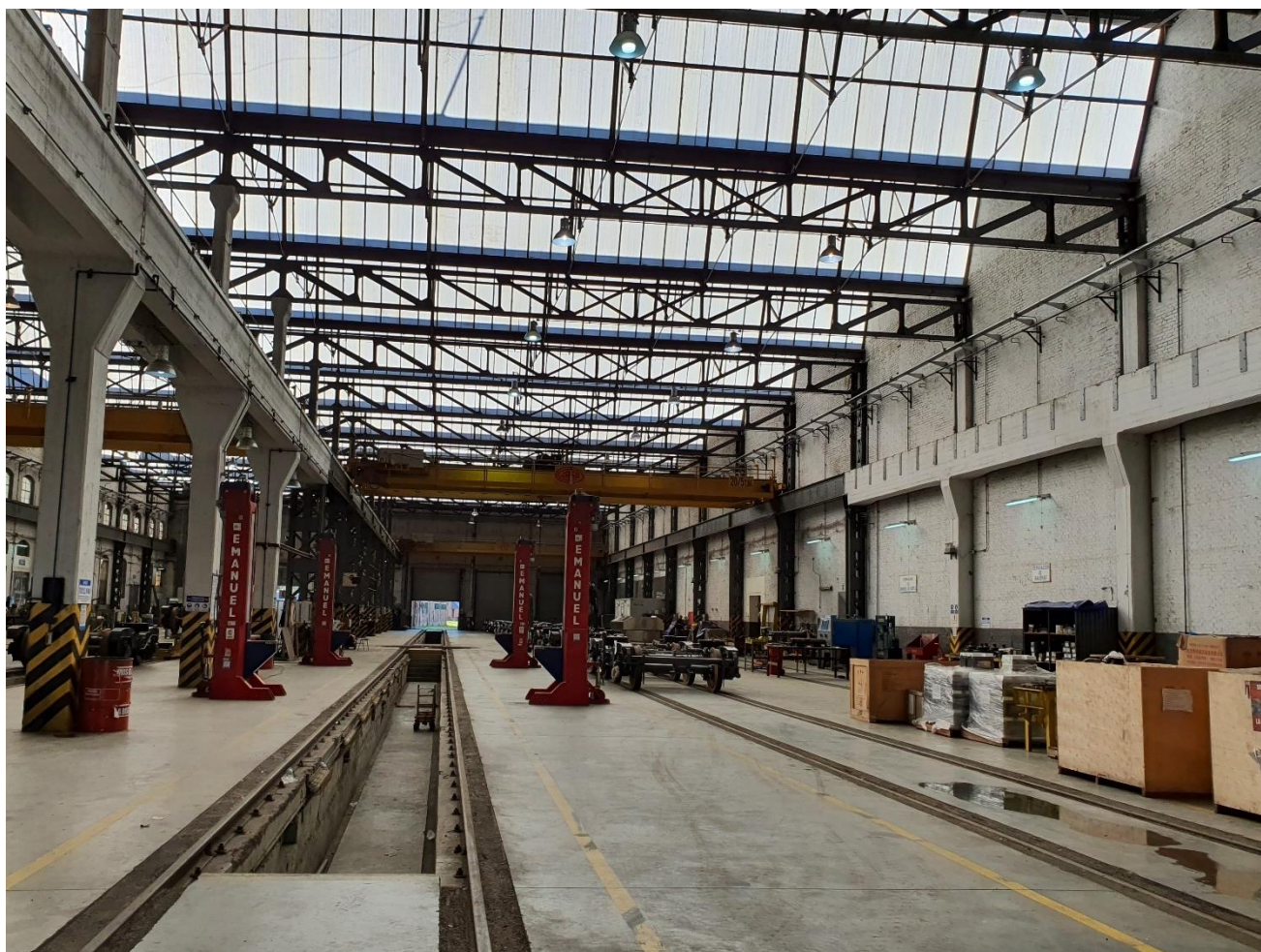
Puente grúa existente en el Taller de Coches
