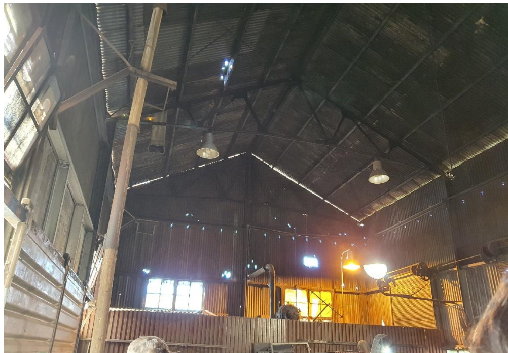
- Taller de Herrería Existente (Interior)
