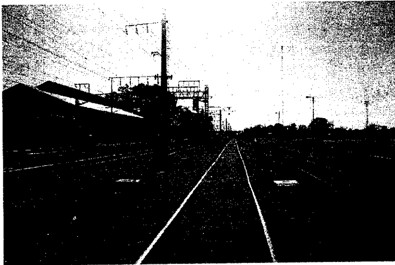
Fotografía 3: Estado actual de Vía 51, empalme vía ya renovada (06/2017)
