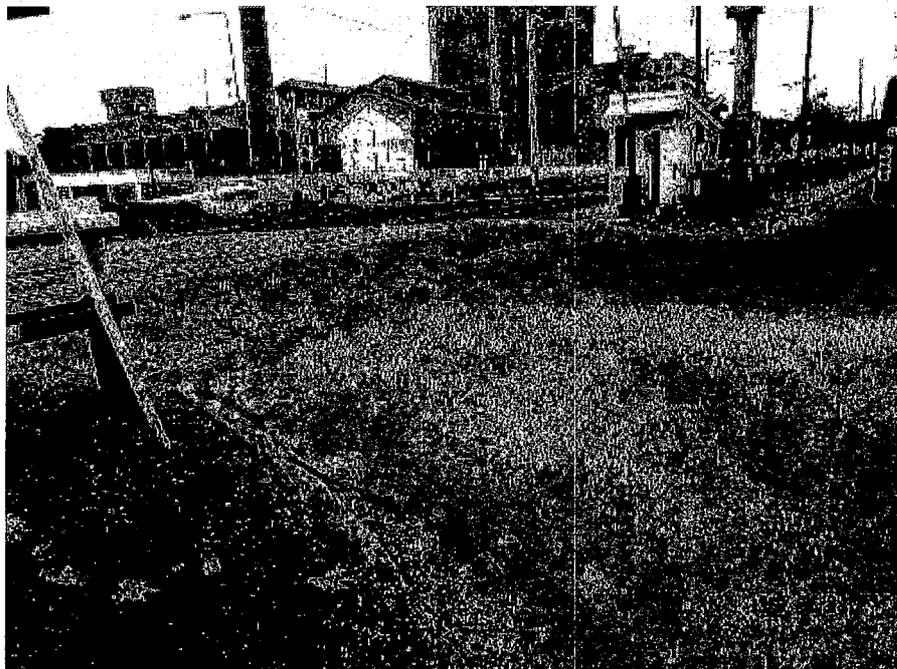
Foto 33: Calzada vehicular y losas de aproximación en mal estado. Sin cordones.
