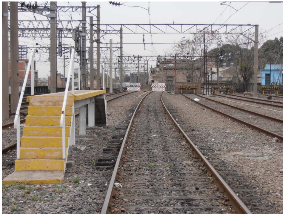
Fotografía 1 Vista del sector de Paragolpes V1 y V2, donde deberán realizarse los trabajos
