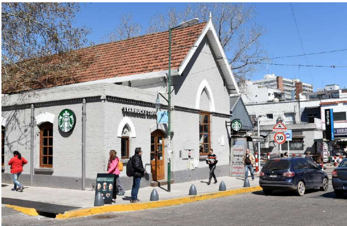
Imagen: Edificio de Estación como Bien Comercial en Estación Martínez, Línea Mitre.
