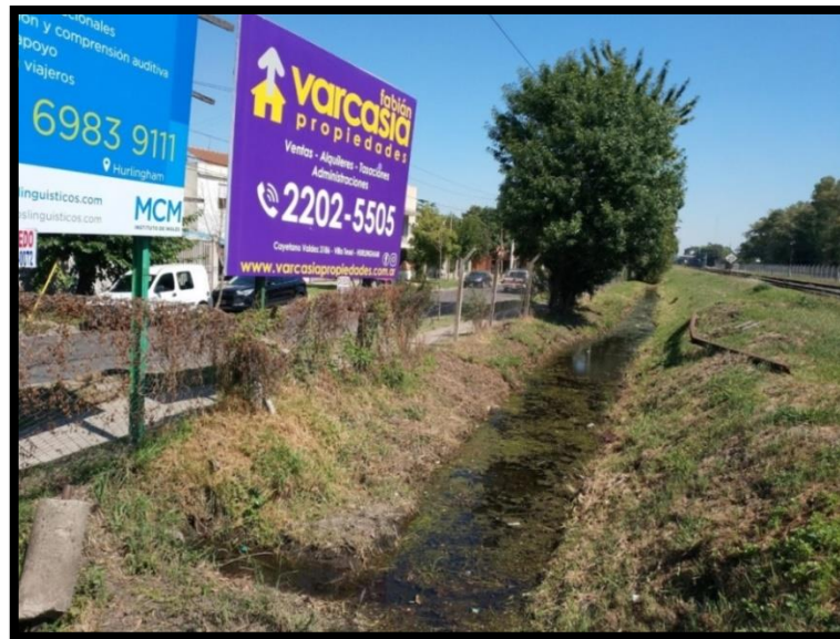
Ilustración 1. PAN Necochea lado Dr. Cabred. Zanja inundada debido al bloqueo
