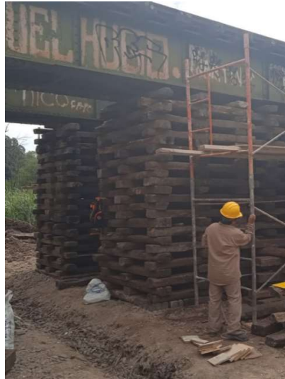
Apuntalamiento tipo Pilastra.
