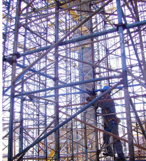
Apuntalamiento tipo Caño y Nudo.
