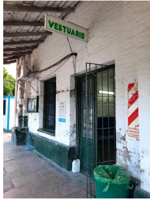
Entrada local ferroviario
