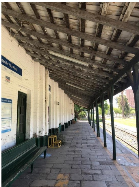
Techo andén a reemplazar
