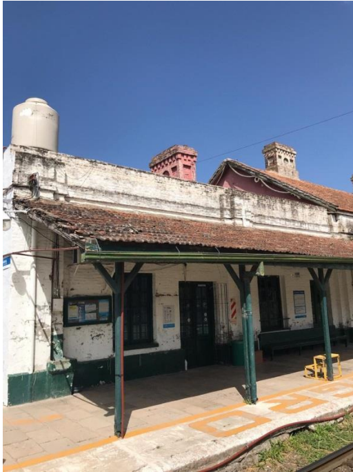
Vista Frontal, con tanque de agua
