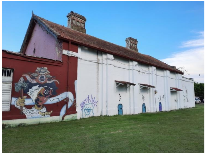
Vista Frente Área Municipal
