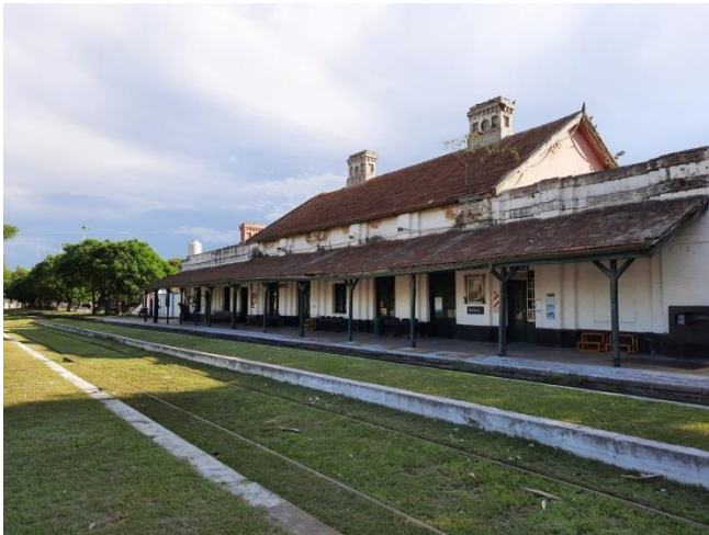
Vista Frente Andén
