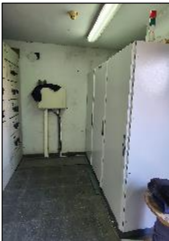
TTA-1 en servicio, sitio de toma de suministro y señal de comando, para el nuevo TGBT-1.
