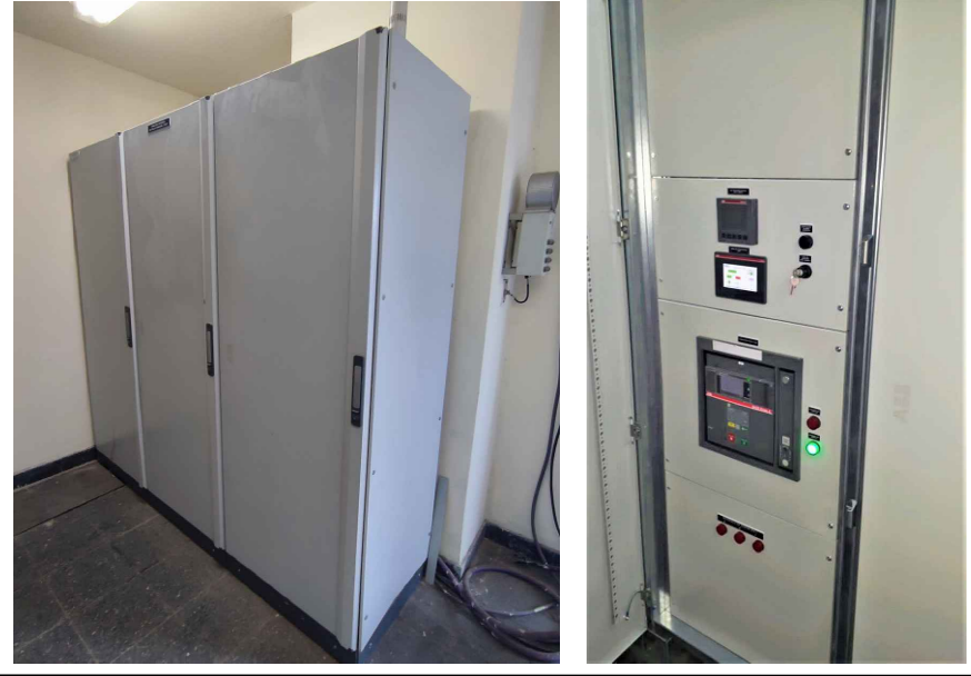
DETALLE TTA-1, SITIO DE TOMA DE SUMINISTRO Y SEÑAL DE COMANDO PARA EL NUEVO TGBT-1.
