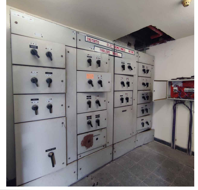
TGBT-1 A REEMPLAZAR Y DESMONTAR POR LA OBRA.
