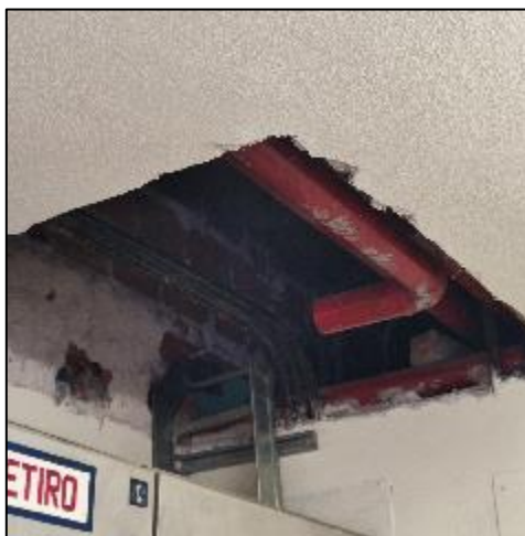
Sala del TGBT-1 a reemplazar, fotografías TGBT-1 y espacio libre, entre falso cielorraso y losa.
