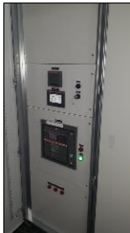
TTA-1 en servicio, sitio de toma de suministro y señal de comando, para el nuevo TGBT-1.
