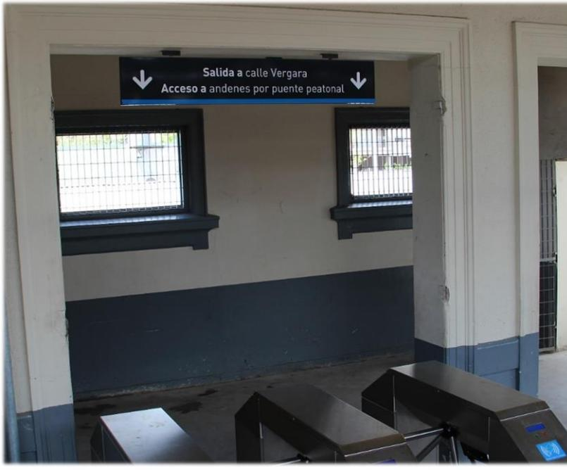
Ubicación: la Señal de Acceso a los Molinetes va ubicada en todos los accesos a andenes en los cuales haya molinetes. La misma se fija al cielorraso de la estación, módulos SUBE y/o refugios existentes. Siempre alineada a los molinetes de acceso al andén.
