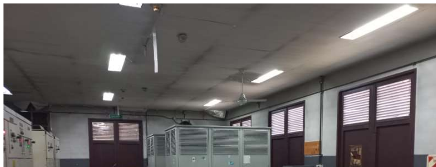
Cielorraso existente a desmontar
